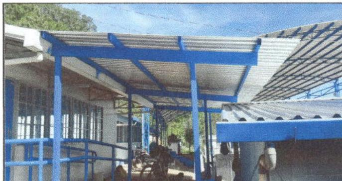
Foto 5: COMPLEMENTO DE TECHO Y ESTRUCTURA DIRECCIÓN BODEGA Y MODULO PREPRIMARIA
